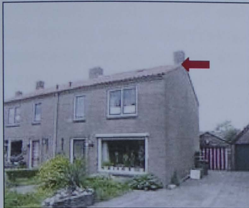
Kolonieplaats in twee-onder-één-kap-woning Foto Daniel Tuitert
