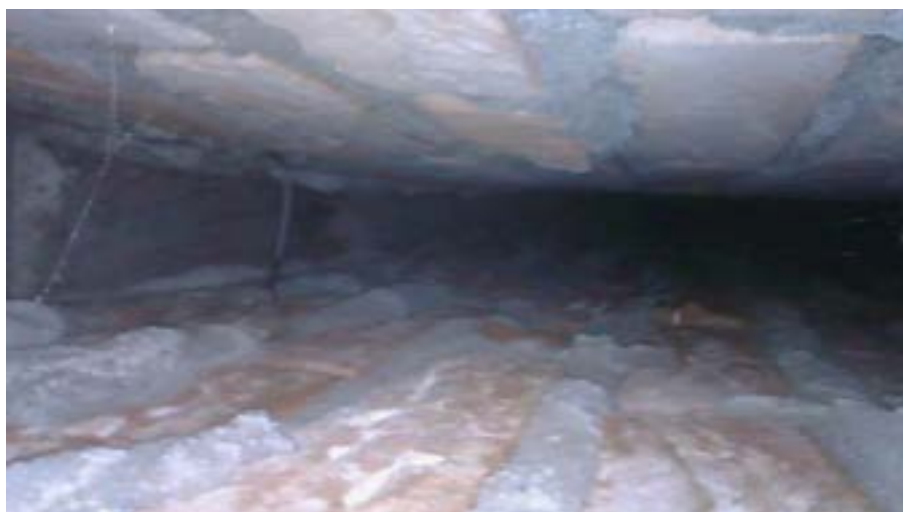
Figuur 5: Opname met een spouwen-scoop van een spouw. Bakstenen zijn 20 cm lang en er zijn tenminste 2 rijen bakstenen te zien, zodat tenminste 50 cm ver gekeken kan worden in een spouw. Opname Peter Twisk.
