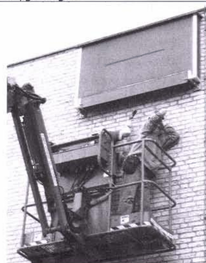
Foto 6: kastcontrole met hoogwerker
