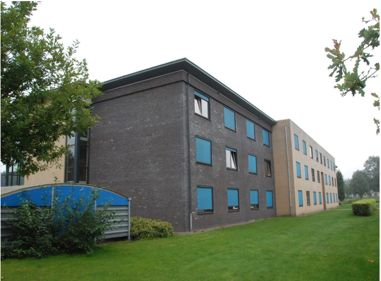
Figuur 3: Gebouw 506. Onder de overstek is een boeiboordkast aangebracht, bekleed met steenstrips in dezelfde kleur. Building 506. Under the eaves, a fascia-shaped bat box has been constructed. The surface is made of masonry veneer panels in the same colour. Foto: Ruud Kaal
