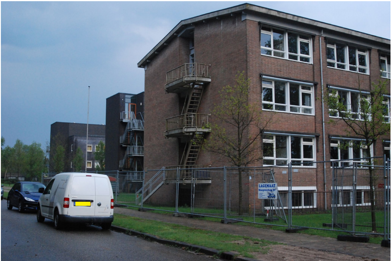
Figuur 2: Gebouw 8, in 2015 afgebroken. In de kopgevels zaten baksteenroosters die als invliegopening werden gebruikt door tot wel 21 laatvliegers. Building 8, demolished in 2015. In the end facade, masonry ventilation grids were in use as roost entrances for up to 21 serotines. Foto: Ruud Kaal.
